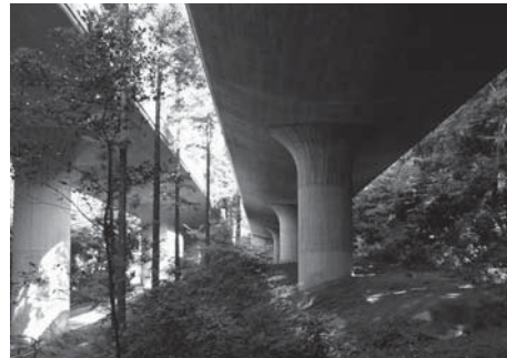
陣ヶ下高架橋/2001
