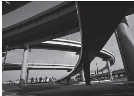
辰巳の森歩道橋/1979
