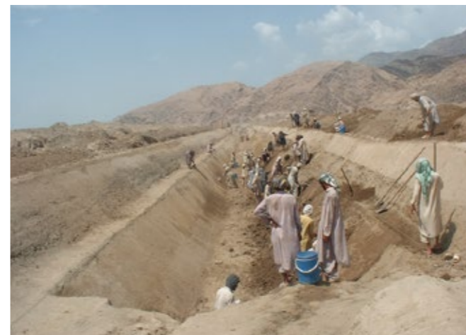
マルワリード用水路 E地区 工事風景(2003年)
