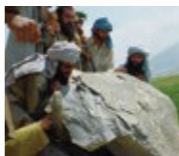
水路の建設作業員は全て近隣農民
