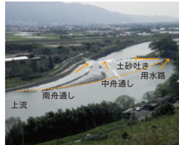
山田堰 江戸時代、干ばつで苦しんだ農民を救うために設けられた山田堰は、改修を重ね、現在の形になった
