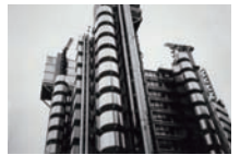
1984 ロイズオブロンドン (リチャード・ロジャース)
