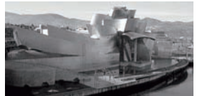
1997 ビルバオ・グッゲンハイム美術館 (フランク・O・ゲーリー)
